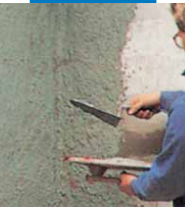
Нанесение цементных составов с добавлением Planicrete
