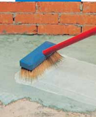
Нанесение адгезионного цементного раствора с добавлением Planicrete
