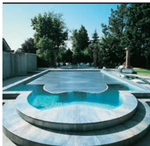
Подземное сооружение в частном бассейне
